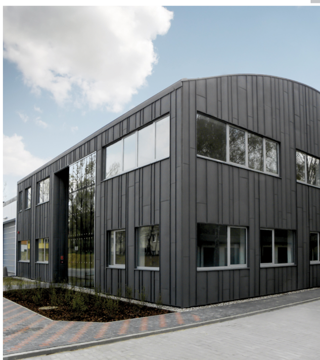
Laboratoire d'essais non destructifs - Varsovie
