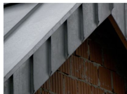
Fot. 10 Różne warianty wykonania wiatrownicy a) płaska b) szeroka na rąbek
