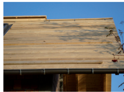
Fot. 11. Deskowanie pełne
