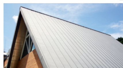
Fot. 1. Pokrycie dachu
