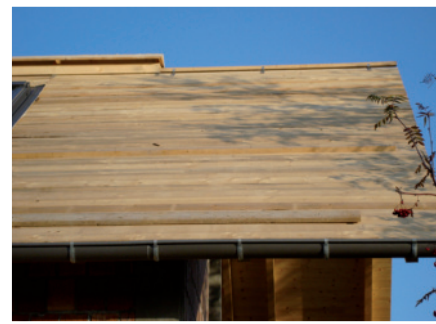
Fot. 11. Deskowanie pełne
