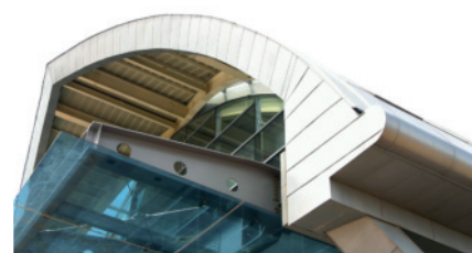
Fot. 2. Obróbki blacharskie
