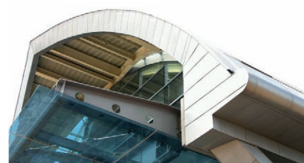
Fot. 2. Obróbki blacharskie
