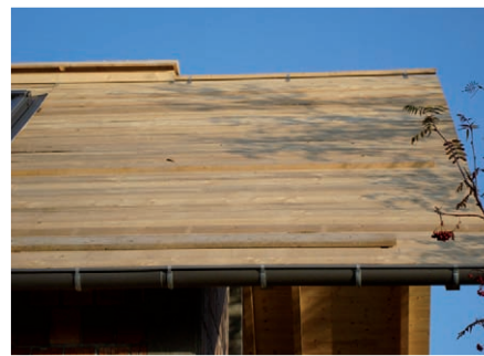
Fot. 11. Deskowanie pełne
