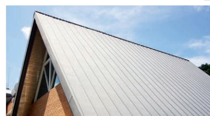
Fot. 1. Pokrycie dachu
